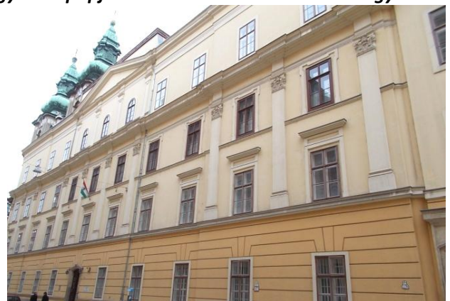
A budapesti Szeminárium épülete
